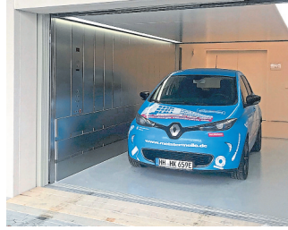
Die Lastenaufzüge können bis zu elf Tonnen tragen.
